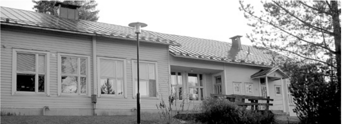
Ohkolan koulun ylätalo. Tilapalvelun toimesta on aivan viimeaikoina korjattu talon vesikatto ja ikkunat.
