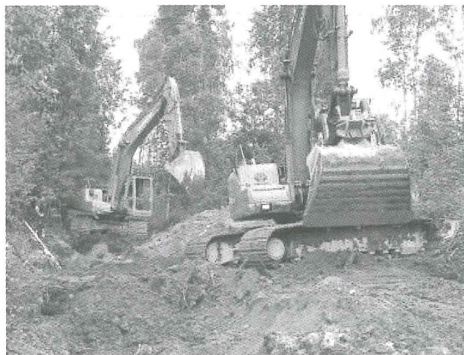
Viettoviemärin asennusta metsäosuudella Kortistonkulmalla.
