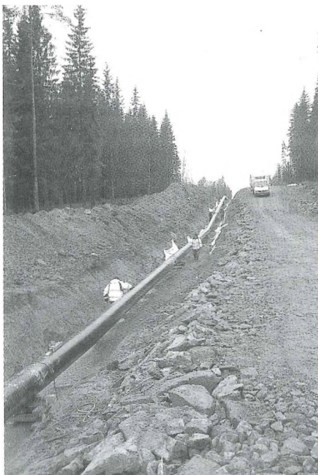
Näkymä asennustieltä maakaasuputkikaivantoon, jossa röntgenkuvaajat ja pinnoittajat työskentelevät.
