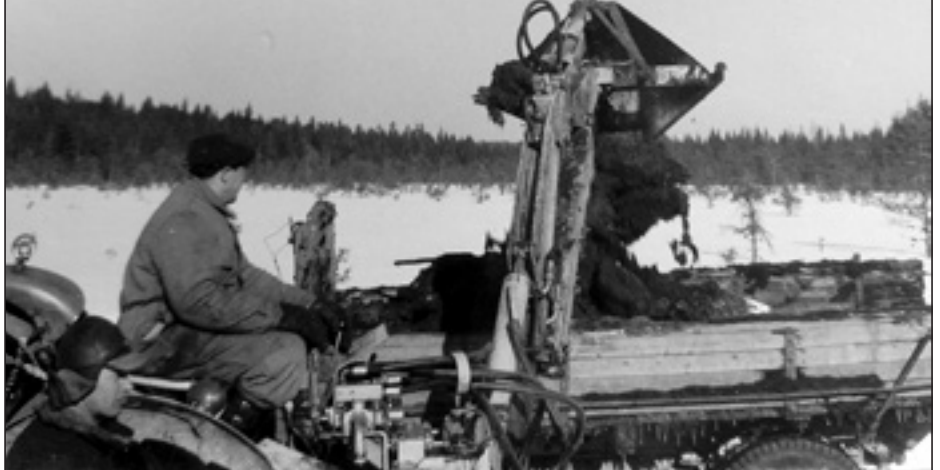
Tällä kaivinkoneella Olavi urakoi ojankaivuuta ja talonpohjia.
