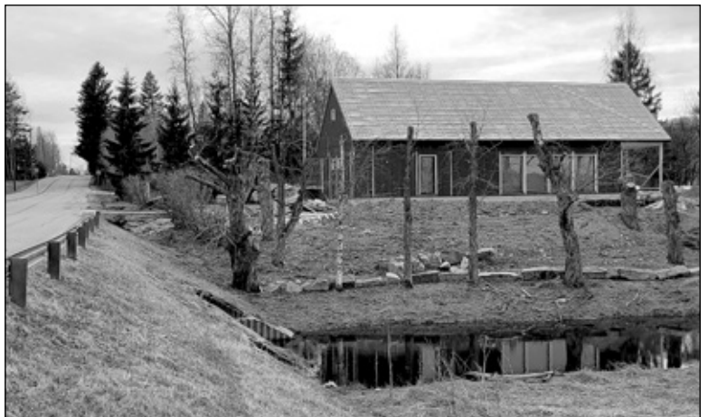
Jokisillan kupeessa entinen postina toiminut kiinteistö on purettu ja uudisrakennus on rakenteilla. Ohkolan koulun opettaja Maija Tikka perheineen tekee tähän omaa kotia. Perheen isä Sami rakentaa taloa valmiiksi ja muutto tapahtuu heti, kun se on valmis. Lapset Taisto 11-v. ja kaksoset Hilja ja Aatos 8-v. aloittivat Ohkolan koulussa viime syksynä. Kuva: Eija Hynninen
