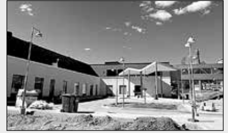
Ohkolan sairaalan uudisrakennuksen sisäänkäynnin edessä pihatyöt edistyvät vauhdilla!
